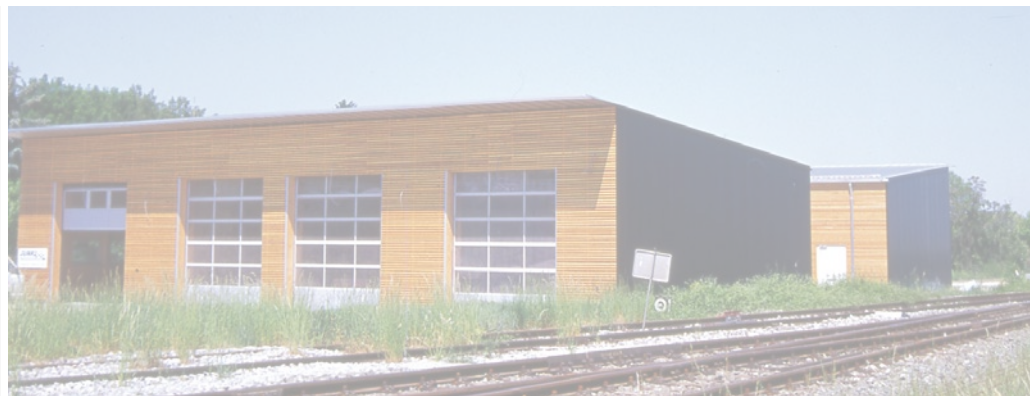
Das Funktionsprinzip von SolarWall: Ein Lochblech erhitzt sich dank Sonneneinstrahlung. Die Wärme wird sogleich über die angesaugte Luft abtransportiert. Der Wiener Architekt Georg W. Reinberg erkannte die Vorteile und stattete das Feuerwehrhaus von Tattendorf damit aus.
